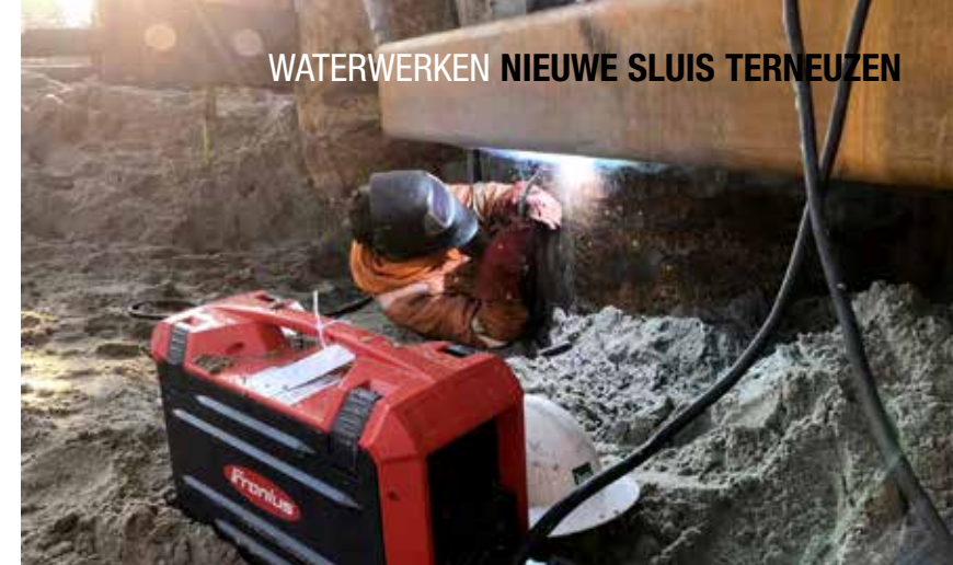
Het project in Terneuzen is voor Rijnberg BV een flinke klus. De firma heeft onder meer de verankeringsconstructie gemaakt aan de Schependijk en de Goessekade.
